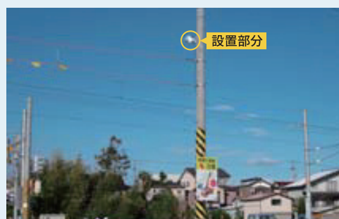
踏切設置(全景)
