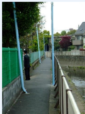
③ジョイント完了最終形
