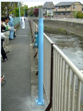
①分割タイプ下柱を設置
