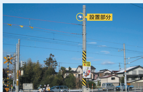
踏切設置(全景)
